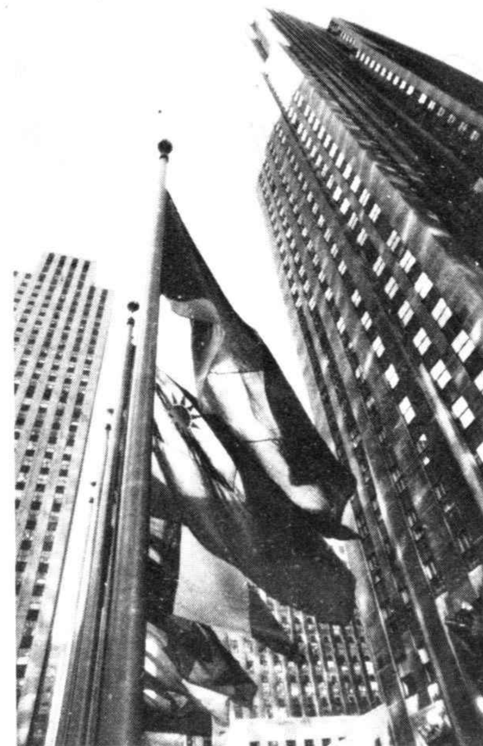
El edificio de la RCA
