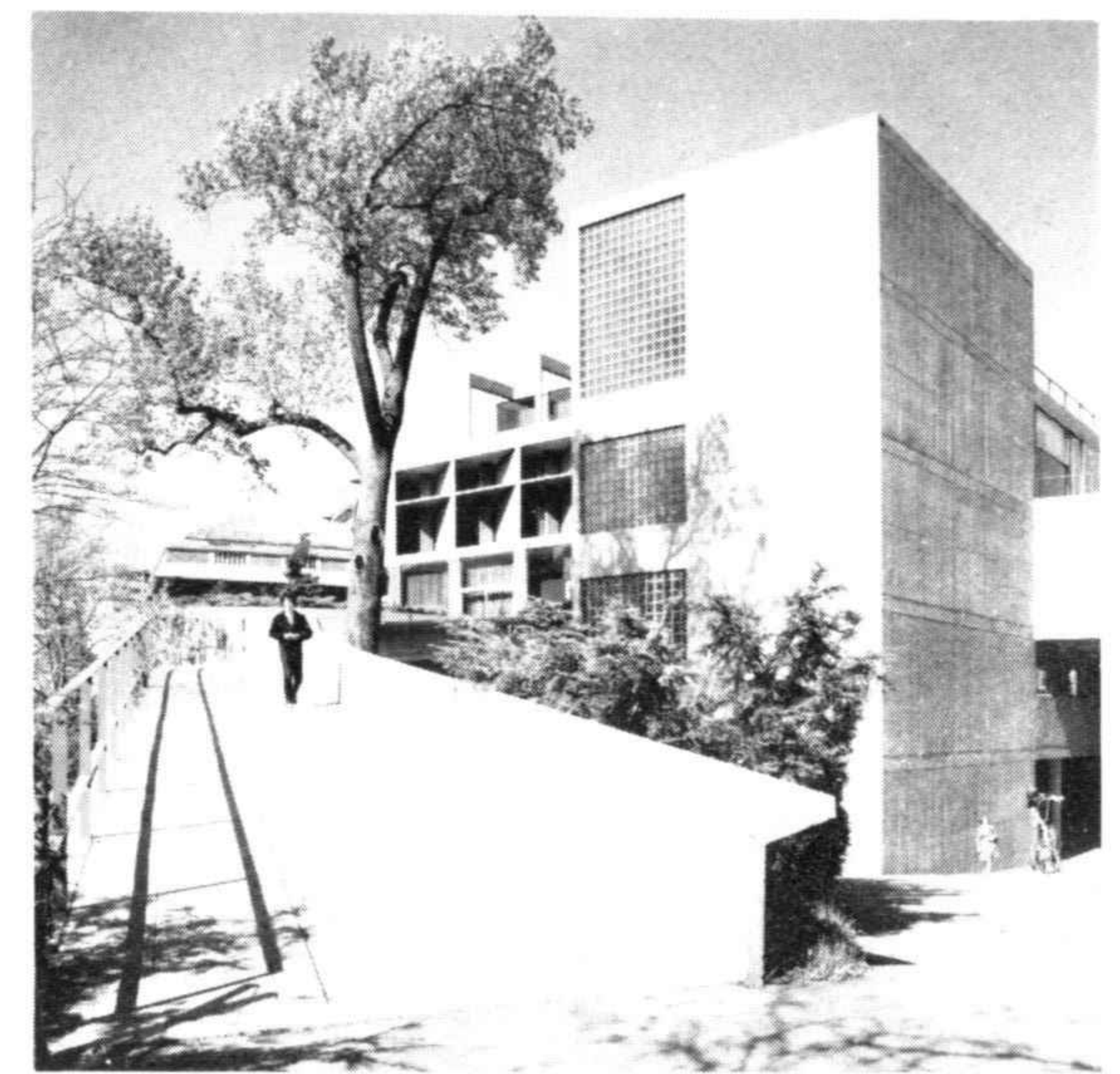
Detalle del Carpenter Center El Carpenter Center, de Le Corbusier, en la Universidad de Harvard, Cambridge (Massachusetts)
