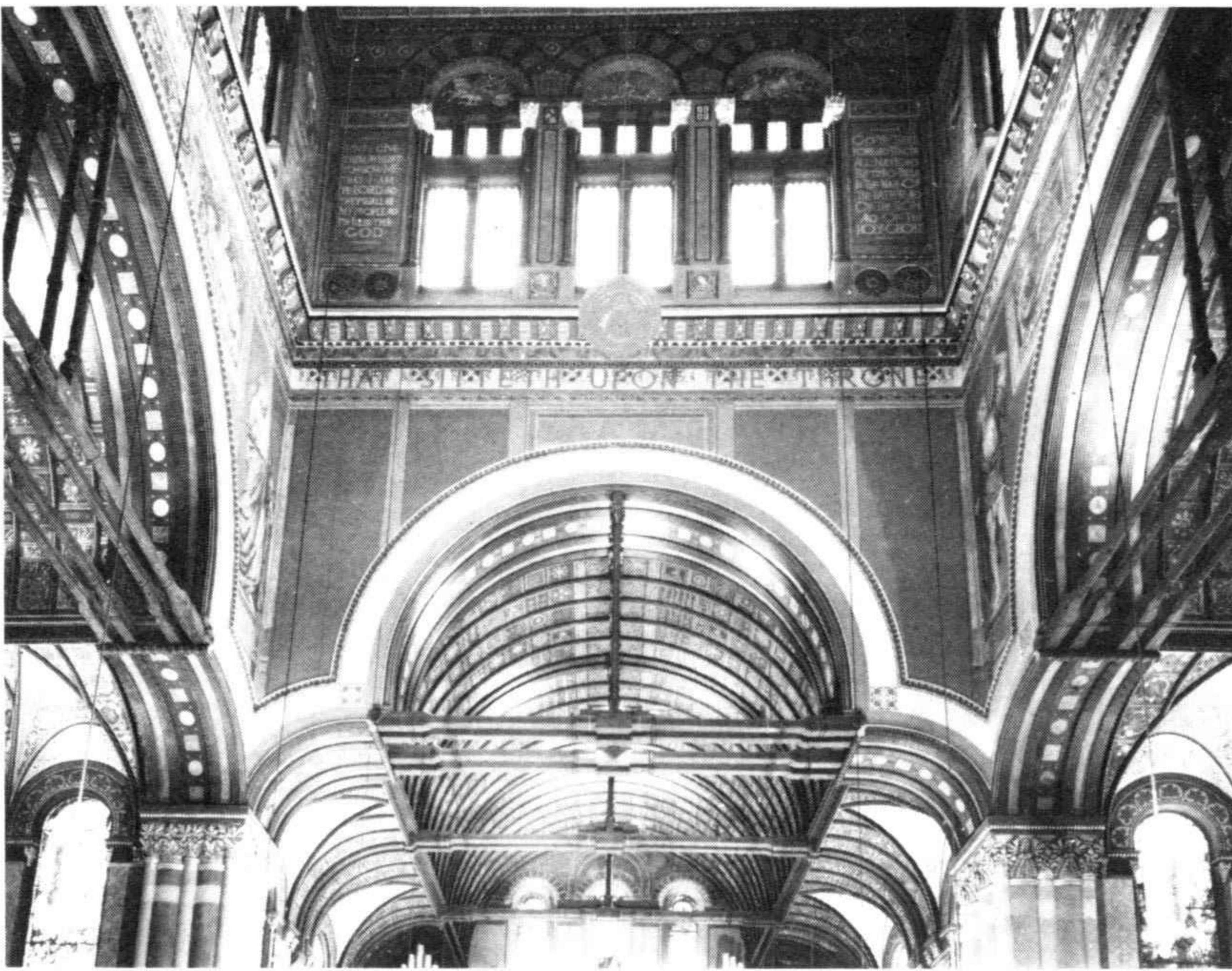
El techo y la torre de la iglesia de la Trinidad
