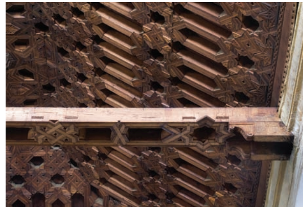
Viga puesta en pares
